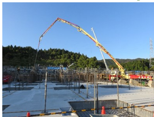
基礎工事の様子
