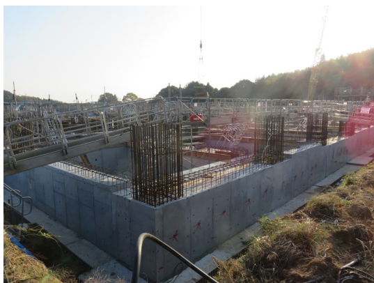
基礎工事の様子
